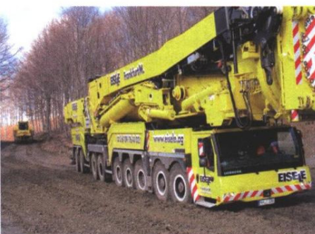
LTM 11200-9.1 kompakt auf neun Achsen: Anfahrt durch unwegsames Gelände zur Windpark-Baustelle bei Kazanlak
