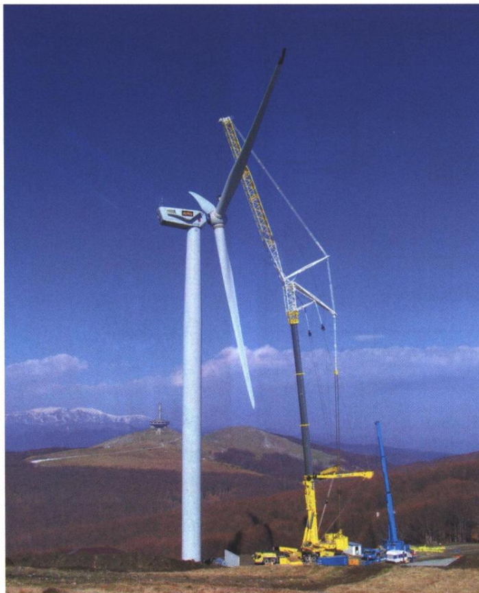
Mobilkran LTM 11200-9.1 in Aktion: Montage des Rotorsterns einer Windkraftanlage
