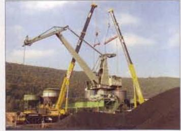
Tandemhub zu Wartungsarbeiten an einem Hafenkran.
